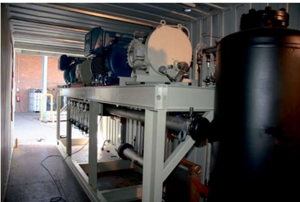
Ombouw van een R22-installatie
